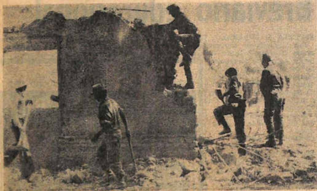
DEMOLICIONES. De las viviendas que quedaron en estado ruinoso, en Las Casuarinas. La ejecutan 140 soldados enviados por una guarnición militar de la provincia de Mendoza. Se trabaja aceleradamente.
