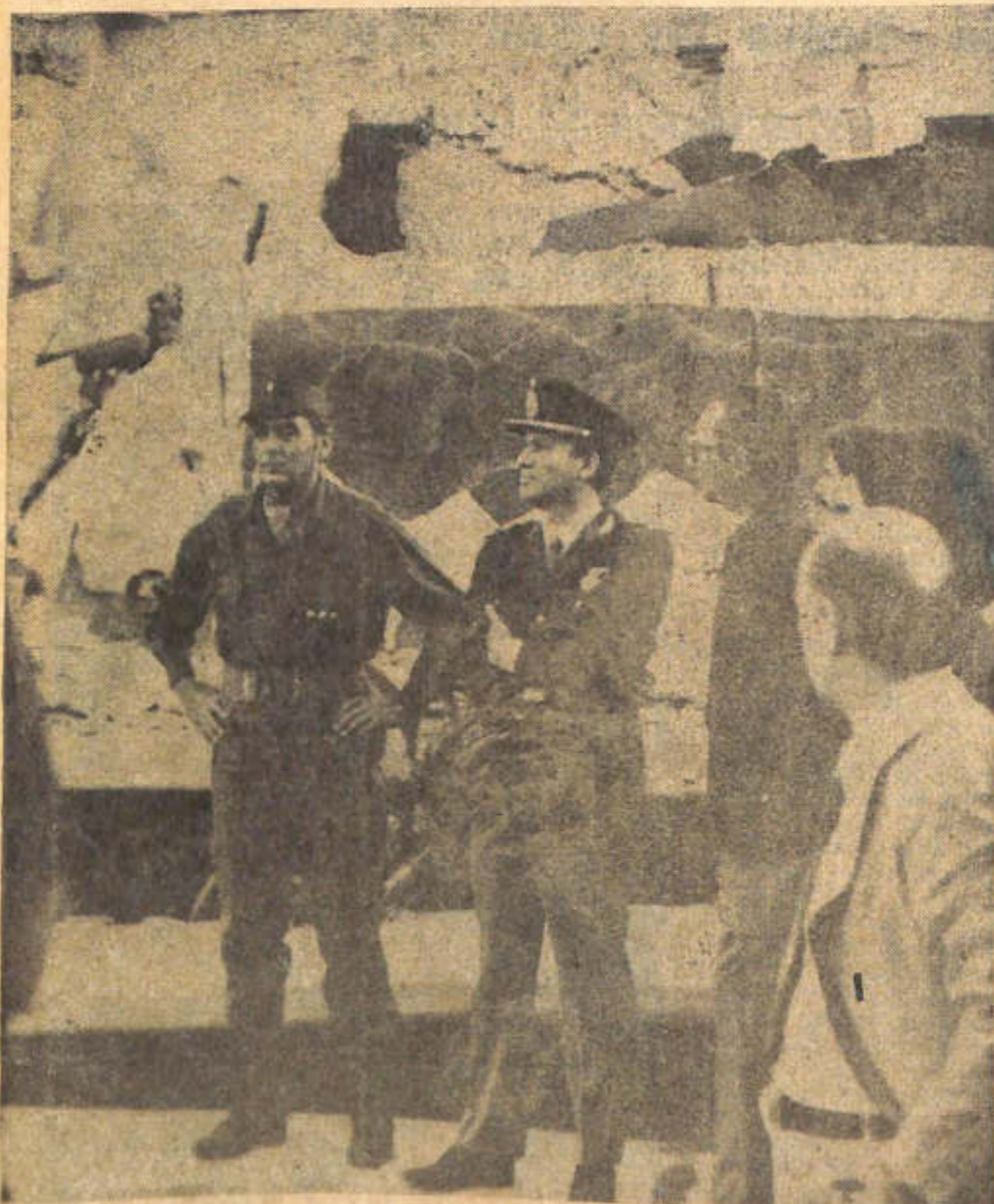
EN LA NORMAL: El coronel Moreno y el señor Ahún flanquean al ministro de Planeamiento de la Nación, general de división Díaz Bessone, quien observa detenidamente las ruinas de lo que fue la Escuela Normal de Caucete.
