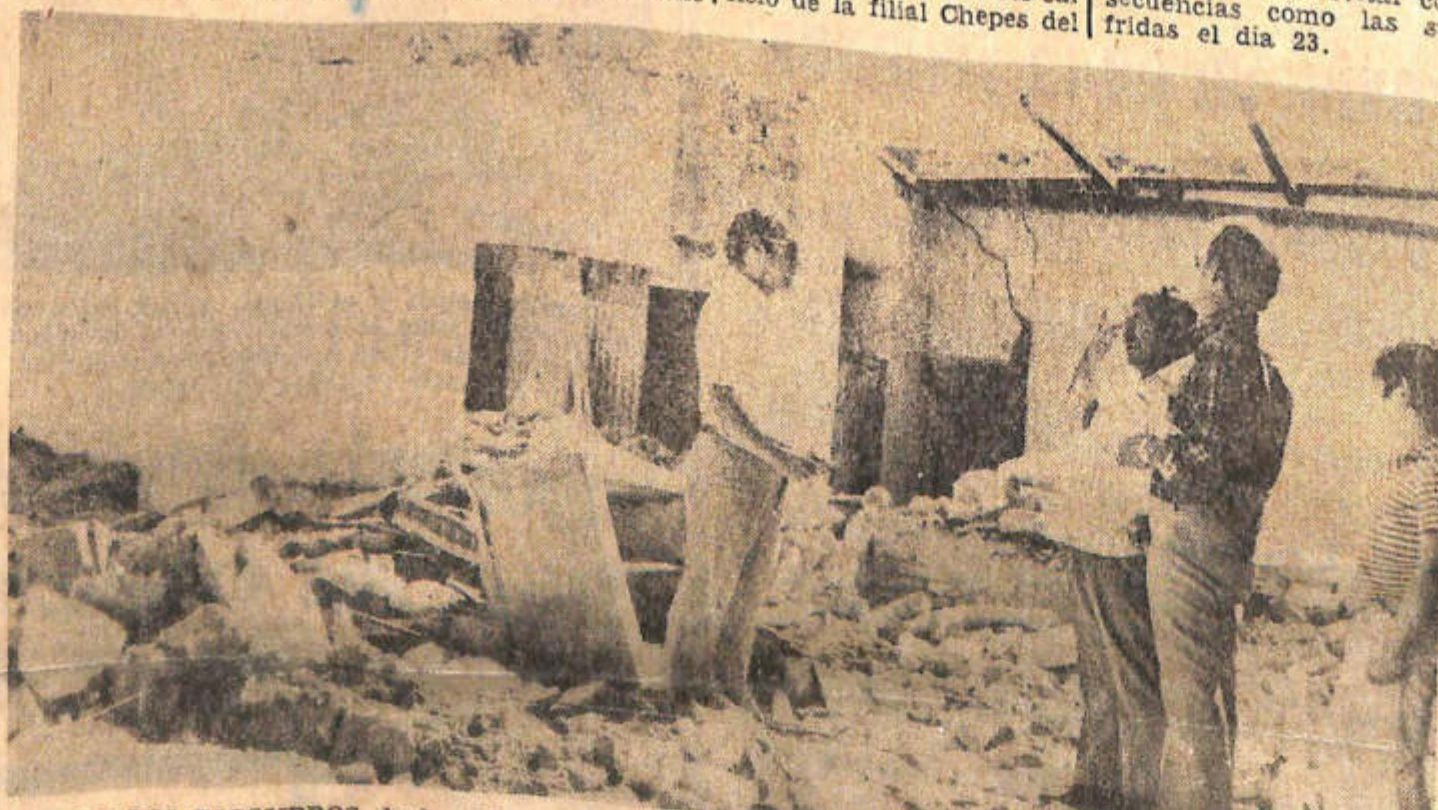
SOBRE LOS ESCOMBROS de la vivienda que ocupaba la familia de Clotilde Pes, en Chepes, La Rioja, se informa a nuestro redactor sobre las consecuencias del fuerte sismo del día 23 del corriente.
