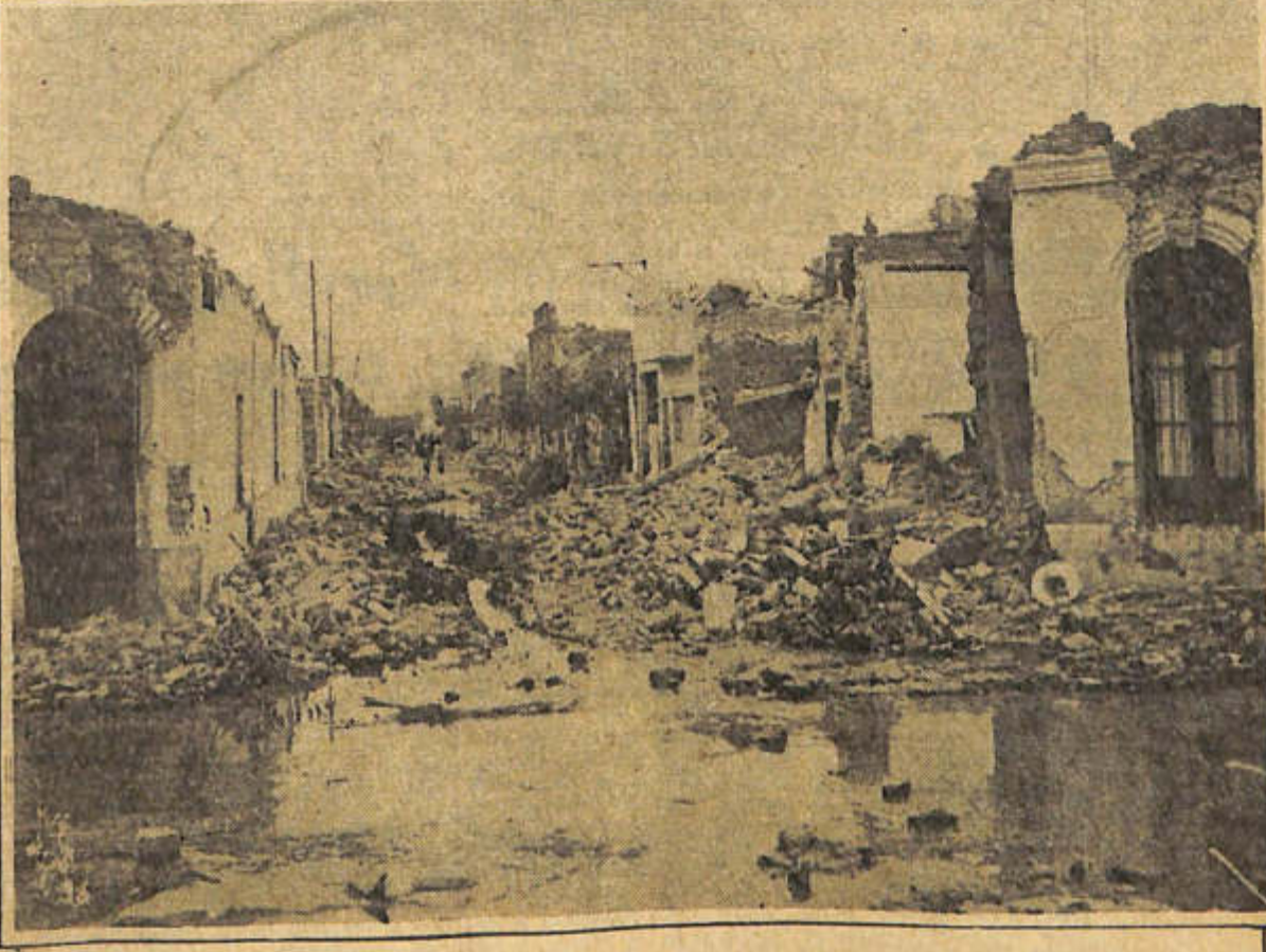
Aspecto que ofrecen las casas de la calle Rioja, perteneciendo los dos edificios que se ven en primer plano a la intersección con la de Córdoba
