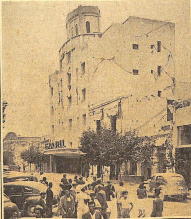
El cine-teatro Estornell, de reciente construcción, ha sufrido resquebrajaduras y se inclinó la torre superior
